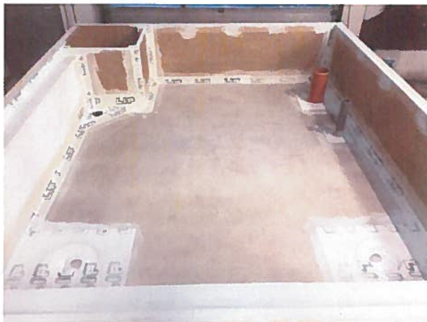
Foto 5. Vandtætning påbegyndt – hjørner mv. er strimlet.
