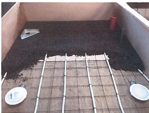
Foto 3. Varmeslanger udlagt og der udstøbes med LIP Thermodyn.
