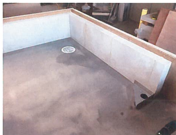
Foto 4. Udstøbning med LIP 220 og montage af "faste" vægge af porebeton.
