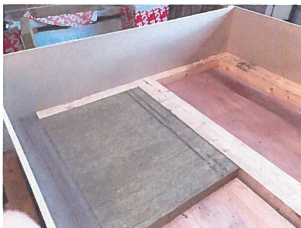
Foto 1. Udlægning af trykfast isolering.
