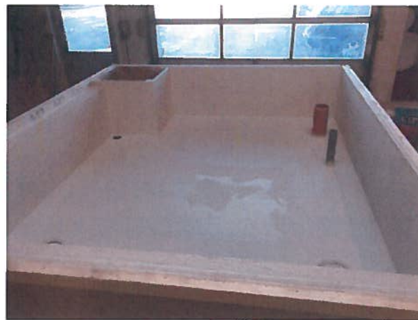
Foto 6. Vandtætningsmembran påført.
