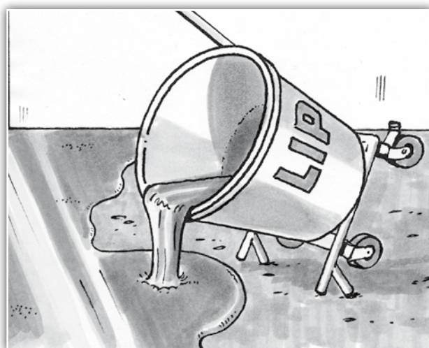
Udhældning af spartelmasse
