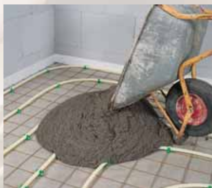
LIP 235 hurtigt pudslag udlægges som traditionel støbning. Konsistensen i pudslaget skal være jordfugtig.
