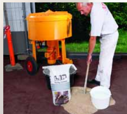
Til fremstilling af LIP 235 hurtigt pudslag anvendes almindelige tvangs- eller fritfalds-blændere.
