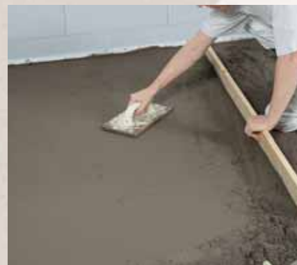
Overfladen i LIP 235 pudslaget skal pudses ensartet sammen, så man opnår en pæn og samlet overflade.
