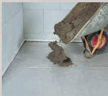
LIP 235 hurtigt pudslaget udlægges som traditionelt pudslag. Konsistensen i pudslaget skal være jordfugtig.
