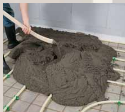
LIP 235 pudslaget udlægges, man skal være omhyggelig med omstøbning af armeringsnet og varmeslanger.
