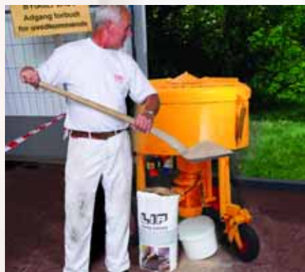
Til fremstilling af LIP 235 hurtigt pudslag anvendes almindelige tvangs- eller fritfaldsblandere.
