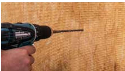
Förborra där termodymlingen ska monteras.
