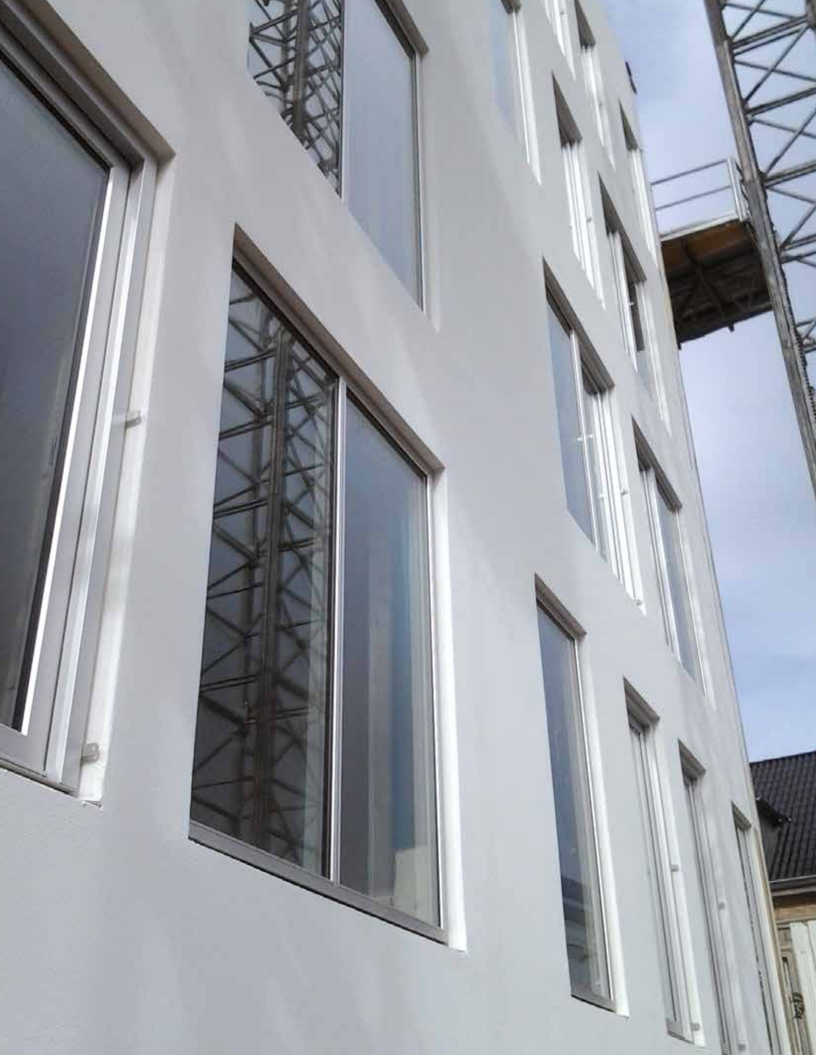
► Kjellerupsgade, Aalborg. Arkitekt: Arkitektfirmaet NORD A/S. Fasadrenovering: LIP Fasadsystem med mineralull, grundputs LIP 350 och slutputs LIP 360.
