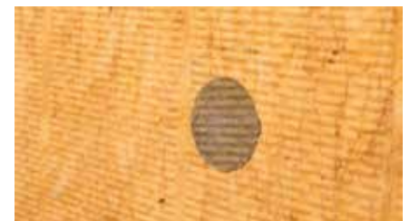
Isoleringsytan är nu klar för grundputs.
