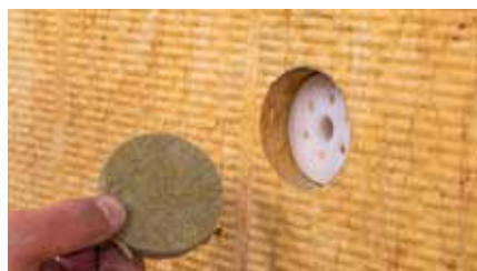
Lämplig isoleringsrondell monteras.
