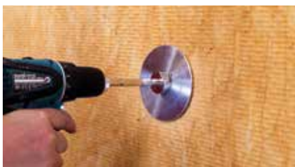
När verktygets krage ligger plant mot isoleringen är dymlingsmonteringen klar.
