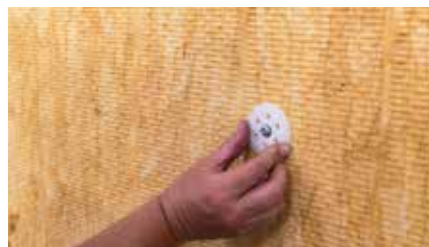
Termodymlingen monteras plant mot isoleringens yta.
