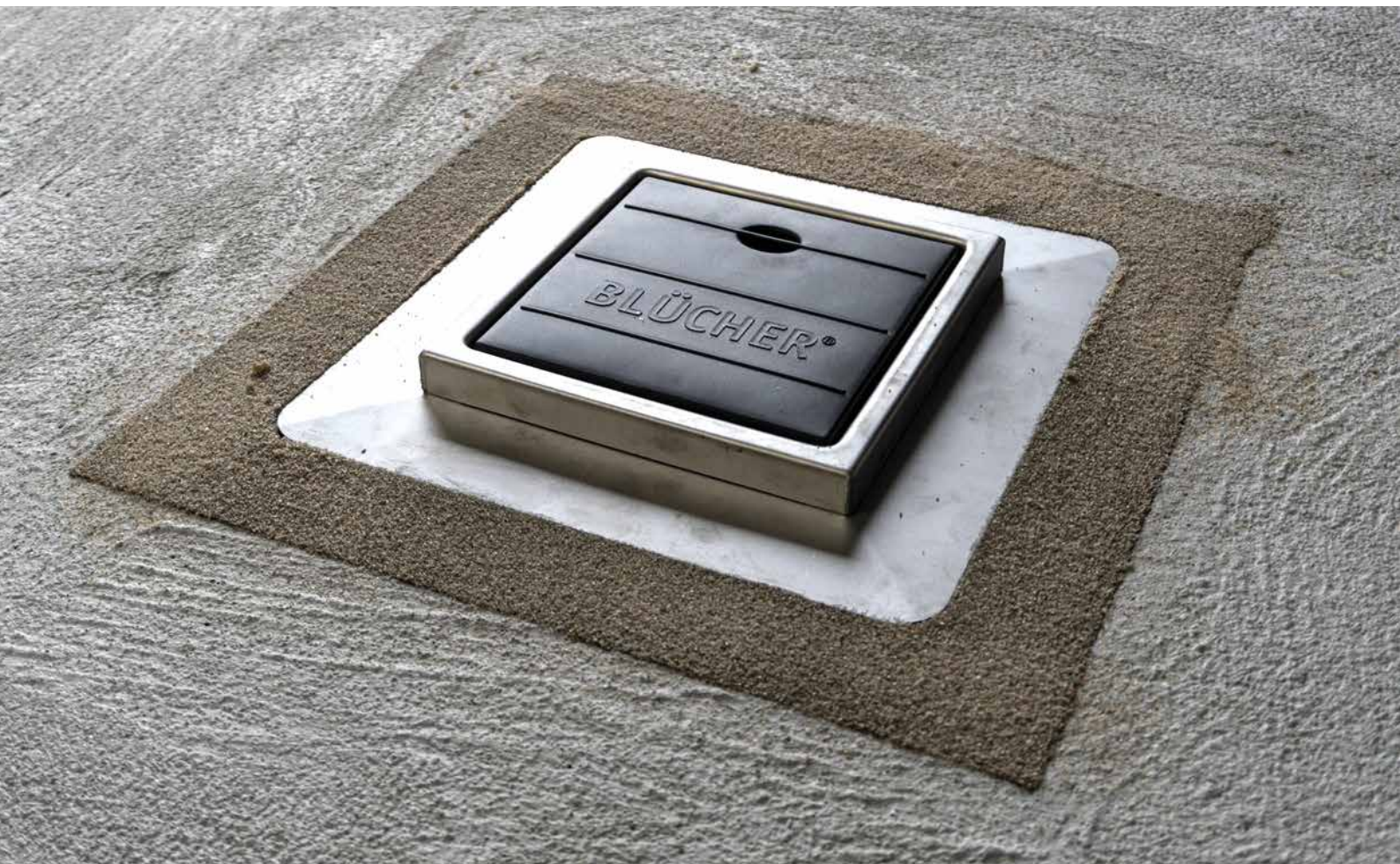
► Gulvfløb klargjort til vådrumsmembran.
