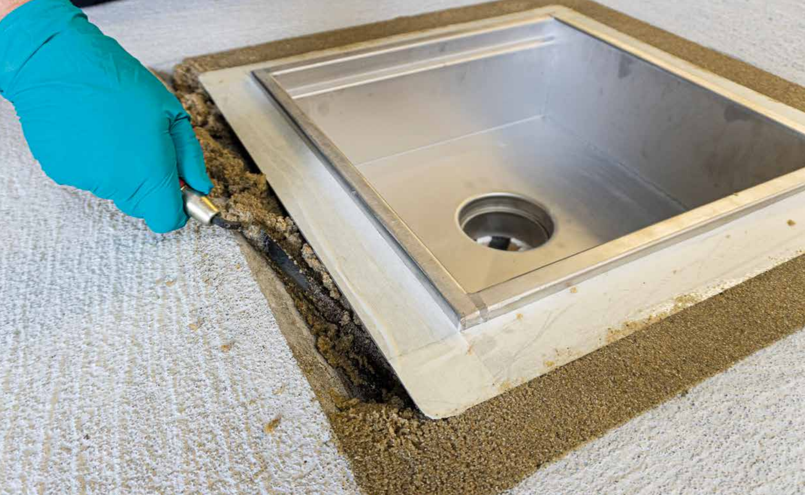
► Installation af LIP 25 Epoxymørtel som kapillarbryder.
