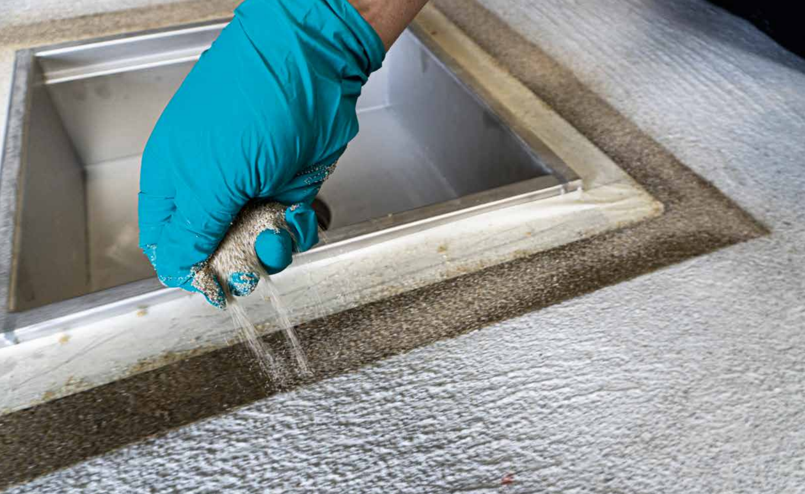
► Påføring af strøsand i den "våde" LIP 25 Epoxymørtel.
