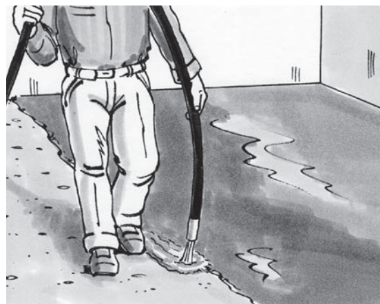
Udlægning med snækkepumpe
