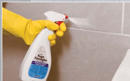
Spraya på LIP Fogförseglare , låt torka i cirka en time, torka bort över ödig fogförsegling med en luddfri trasa.
