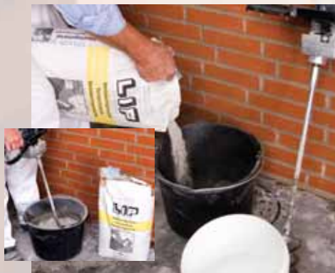
LIP Vandskuringsmørtel opblandes med rent vand. Opblanding foretages med piskeris.
