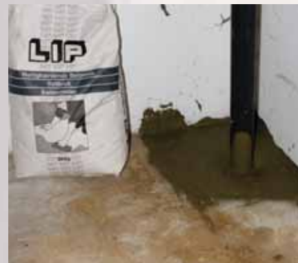
Efter udstøbning er tørretiden kun ca. 3 timer inden produktet igen er gangbart.
