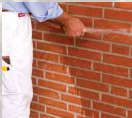
Forvanding af underlaget er vigtigt inden vandskuringsmørtelen påføres.
