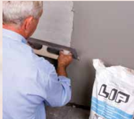
Trækkes på væggen med stålbræt.
