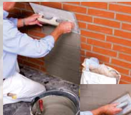
Vandskuringsmørtelen trækkes på underlaget med glat stålbræt.
