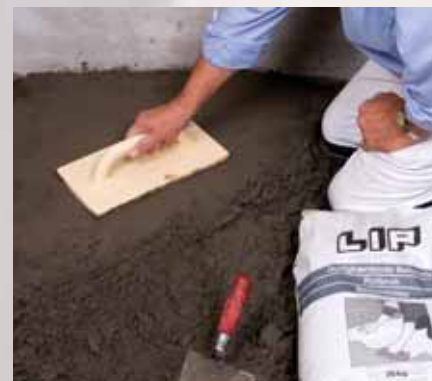
Sammenpudsning af produktet foregår som ved traditionelle betonstøbninger.
