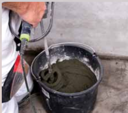
LIP Hurtighærdende Betonmix opblandes i tvangsblender eller ved mindre portioner i spand med piskeris/boremaskine.
