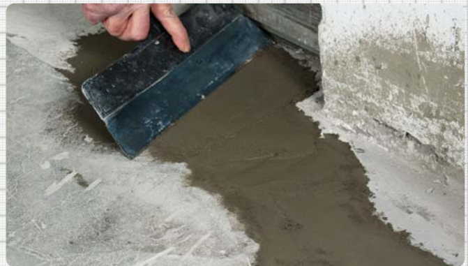
2. Eventuella skador lagas med exempelvis LIP 205 Expresscement .
