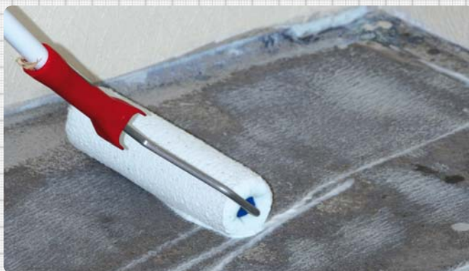
3. Underlagets primas med LIP VS20 Ångspärr som förtunnas med 5 delar vatten (1:5)
