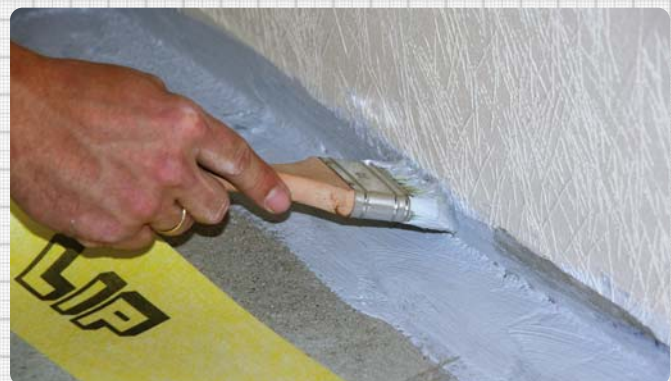
4. Montera LIP ÅT-remsa i det blöta VS30 Vattentätningmembranet .
