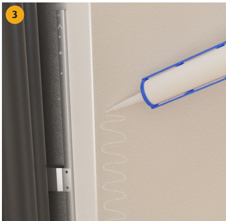
3 Applicera LIP Skarvlim MSP golv- och väggytor som medföljande LK-förseglingsmaterial ska täcka. Sprid sedan ut limmet med en fintandadlimspackel så limmet täcker hela ytan.
