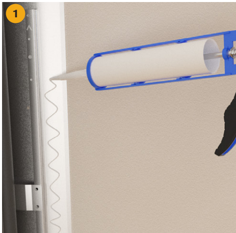
1 Applicering av LIP Skarvlim MSP på Våtrumskassetens fläns/sockel.
